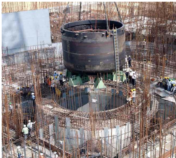
Сооружение АЭС Куданкулам (Индия). Установка ловушки удержания кориума тигельного типа, разработанной с участием специалистов НИТИ
