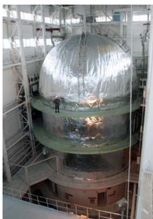
Контейнмент крупномасштабного стенда (КМС) для проведения исследований в обоснование безопасности АЭС с ВВЭР
